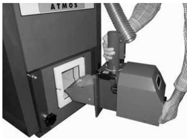
Entnahme des Brenners aus dem Kessel bei der jährlichen Wartung und Reinigung
