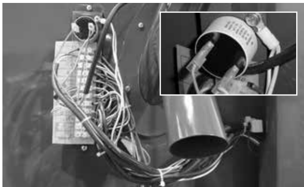
Elektroinstallation des Kessels unter dem vorderen Gehäuse. Anordnung des Anlaufkondensators (1 µF) für den Abluftlüfter (außer PX10).
