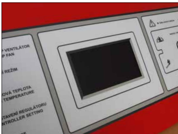
Regulátor v přístrojové kapotě kotle
