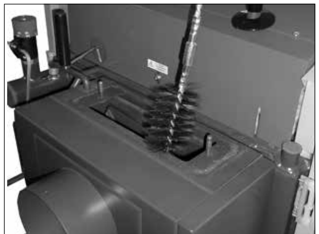
Vorführung der Reinigung des Rauchkanals mit Drahtbürste.
