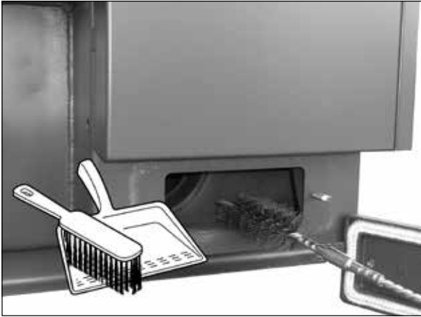
Vorführung der Reinigung des Rauchkanals mit Drahtbürste.
