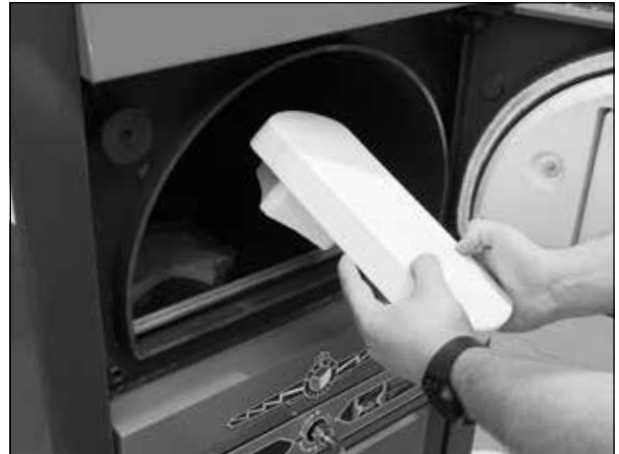
Beispielhafte Installation der Sibral-Blende für Feuerstätte
