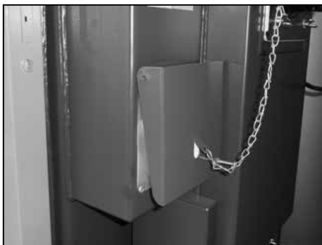
Valve fermée pour l'arrivée d'air de combustion dans la chaudière DCxxSP(X), CxxSP, KCxxSP
