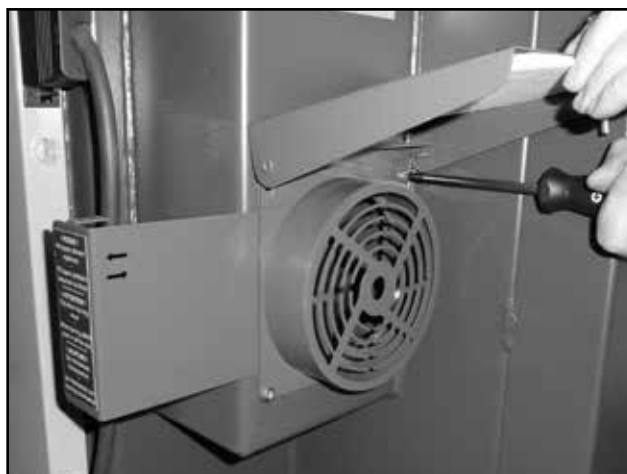
Montage d'une règlette sous la valve avec la grille
