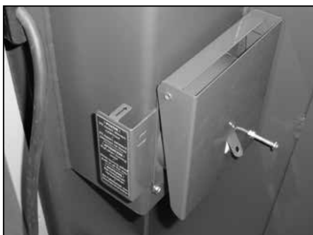
Règlette et valve de réglage fermées pendant le chauffage à pellets
