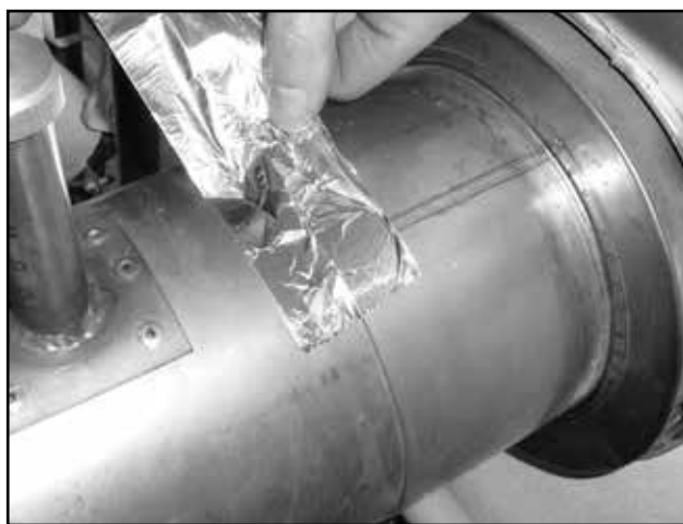
Étanchéité du carneau de fumée par la bande d'aluminium
