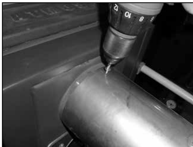
Exemple de sécurisation du carneau de fumée par la vis
