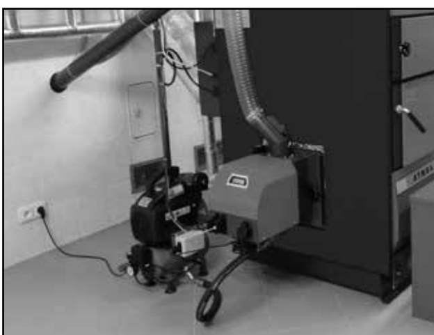
Exemple de la mise en place du compresseur à côté de la chaudière
