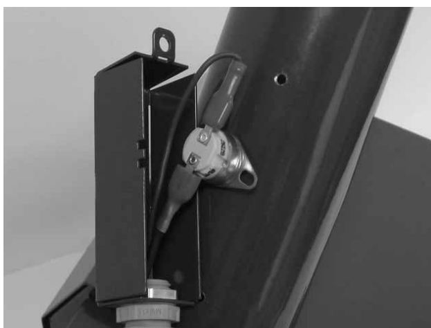
Rys. 10 - Termostat bezpieczeństwa przy zasypie komory spalania, 95 °C
