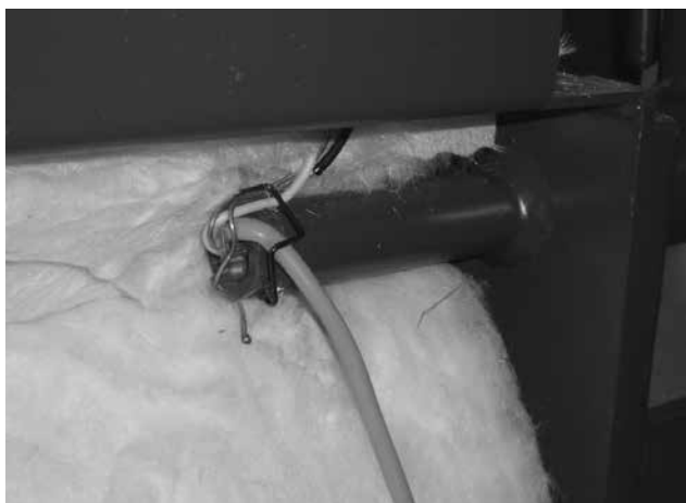
Rys. 15 - widok czujnika temperatury wody TK podłączonego do kotła- DCxxSP(X)/(EP), lub kotłów z palnikiem w górnych drzwiczkach- DCxxS(X), CxxS(T), ACxxS, KCxxS, DCxxRS
