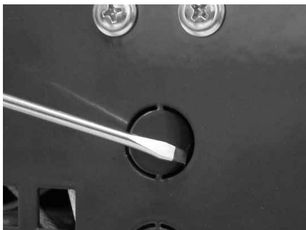
Rys. 11 - zaślepione otwory dla czujników (można wykorzystać do specjalnego użycia w przypadku kotłów z modulem AC07X-C)
