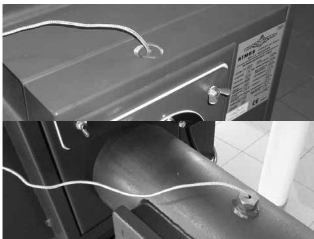
Rys. 14 – Widok czujnika temperatury spalin TS lub TSV podłączonego do łącznika kominowego. Przypadku kotłów D30P, D40P i D50P (D45) znajduje się na kanale dymowym kotła.
