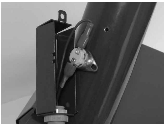
Fig. 10 - thermostat de sécurité sur le tuyau d'amenée des pellets 95 °C
