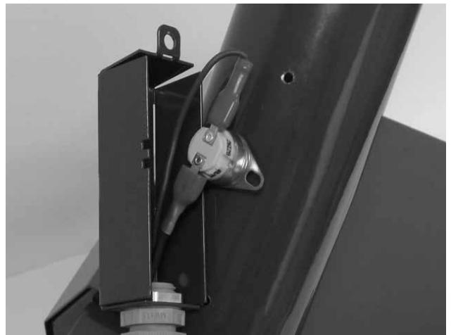
Fig. 10 - thermostat de sécurité sur le tuyau d'amenée des pellets 95 °C
