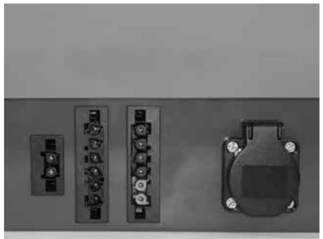
Fig. 12 - brûleur - deux connecteurs à 6 fiches, à gauche le connecteur de puissance, à droit le connecteur pour les capteurs, connecteur pour un câble supplémentaire à 2 fiche (R3 et R4) et la dose d'alimentation du convoyeur
