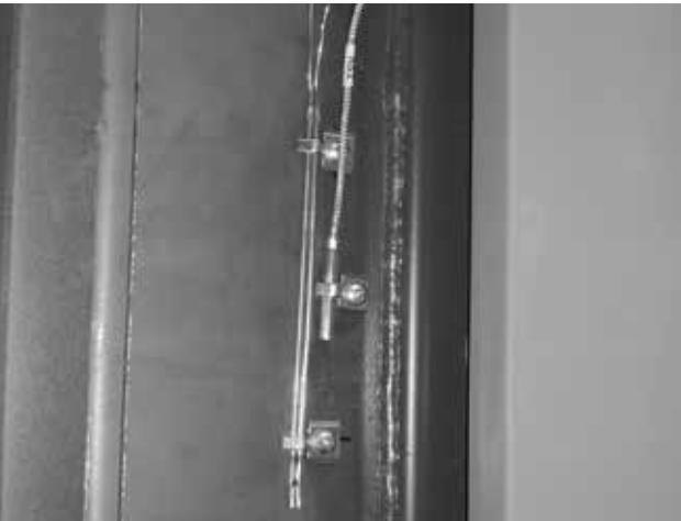
Fig. 15 - vue du capteur des gaz brûlés TSV sur le côté d'un carneau de fumée de la chaudière DCxxGSP
