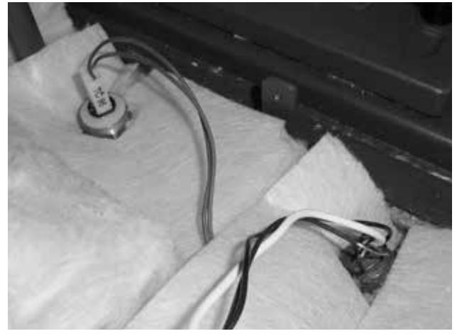
Fig. 16 - vue du capteur de température de l'eau TK dans le bac de la chaudière DxxGSP
