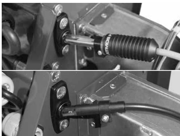
Rys. 4 - fotokomórka - należy uważać na prawidłowy kierunek podłączenia - zaleca się czyszczenie przynajmniej raz w roku nową fotokomórka / stara fotokomórka
