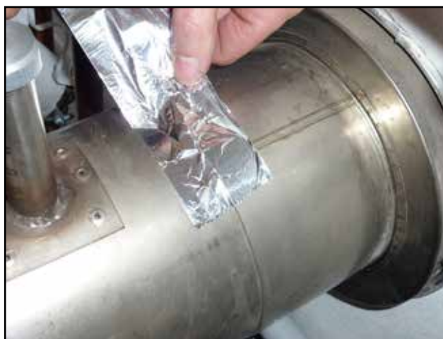
Utěsnění kouřovodu hliníkovou páskou
