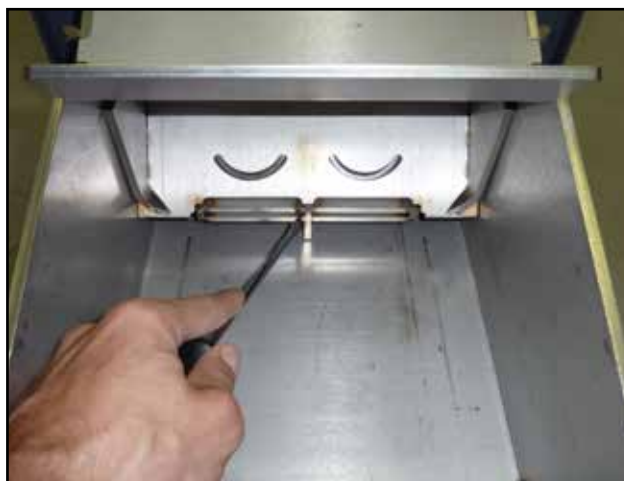
Ukázka čištění přední části kanálu pro přívod stlačeného vzduchu
