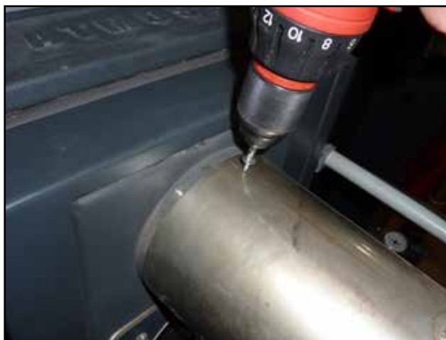
Ukázka zajištění kouřovodu šroubem
