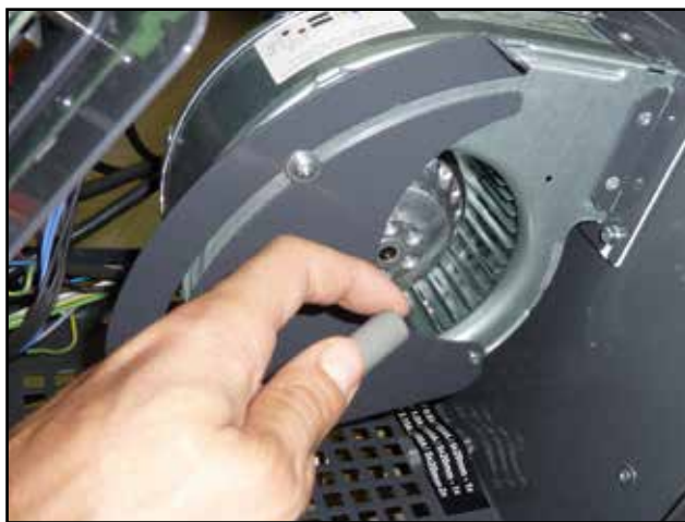
Ukázka čištění (vyfoukání) oběžného kola tlačného ventilátoru hořáku jednou za sezonu.
