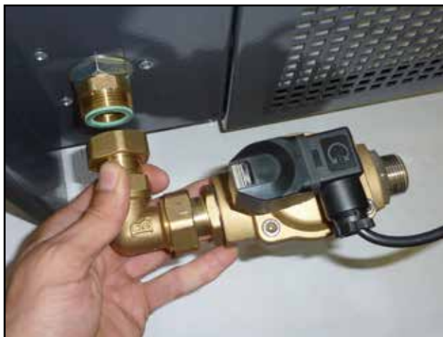
Vezmeme kompletní šroubení s ovládacím elektroventilem a propojovacím kabelem a našroubujeme jej na hořák
