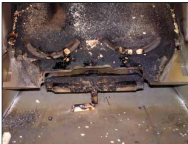
Ukázka lehkého zanesení po 4 měsících provozu
