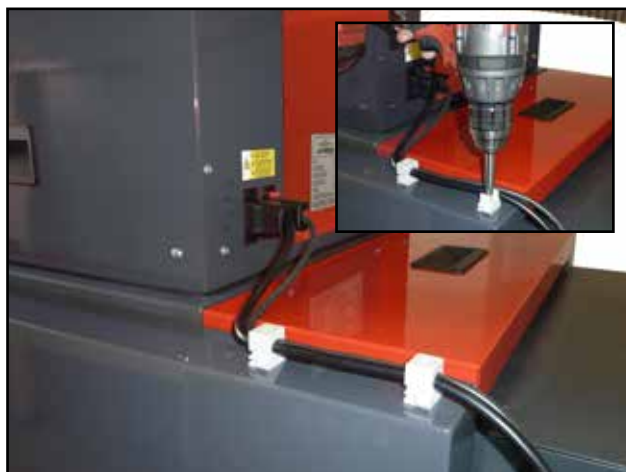
Upevnění držáku kabelů k boční kapotě kotle
