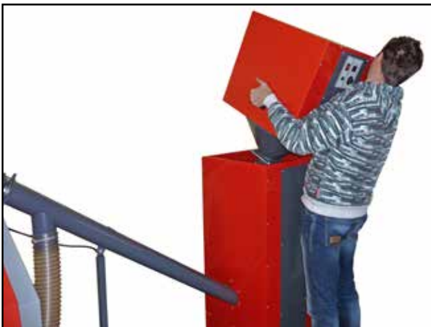
Sejmutí pneumatické dopravy z vyrovnávací nádrže
